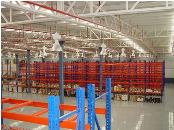
Sistema en acero estructural
