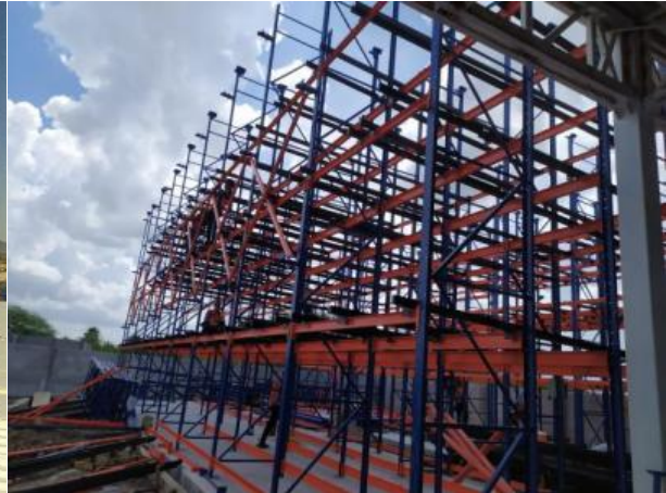
Vigas en naranja y marcos en azul (pintura horneada)
