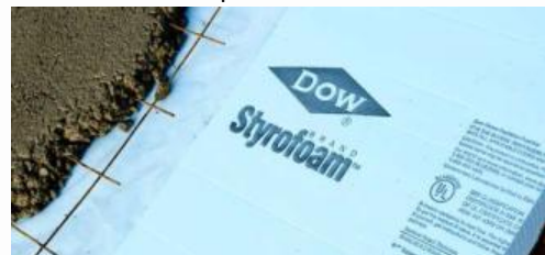
La placa con la malla y una capa de mortero
