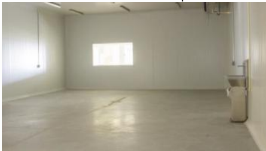
Ejemplo de espacio con concreto pulido
