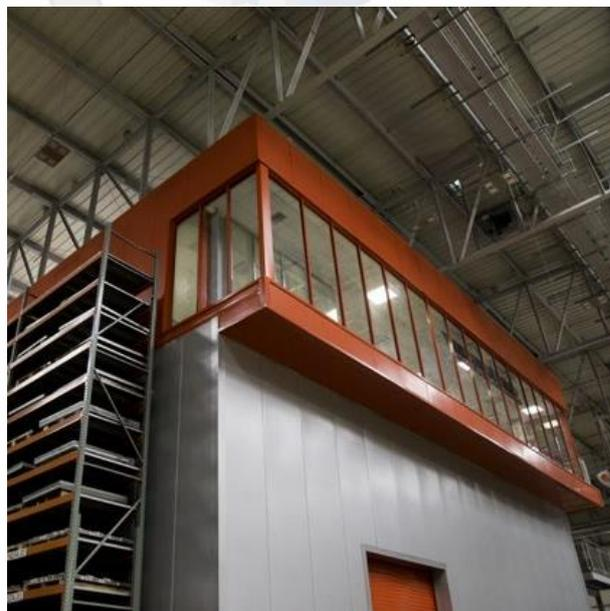
Panel de muro, con aislamiento acústico
