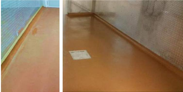
En estas imágenes se observa la aplicación de la curva sanitaria epóxica, brindando protección adicional al piso
