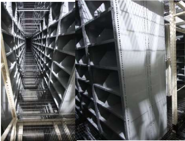
Estanterías dentro de sistema de racks
