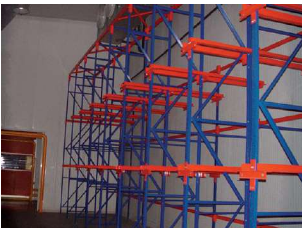
Sistema en acero estructural
