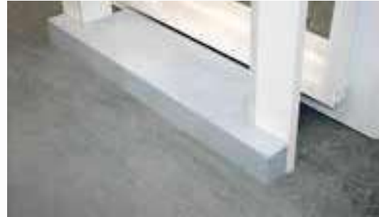
Paso carretilla sobre elevado
