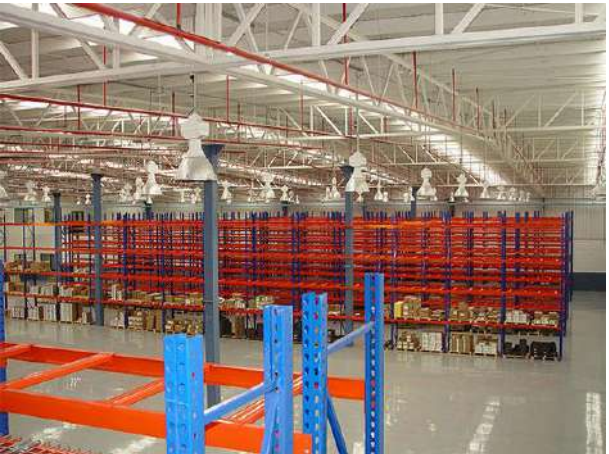
Sistema en acero estructural
