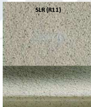
Estructura de la superficie
