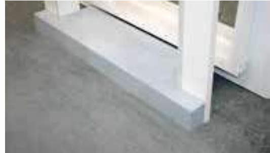
Paso carretilla sobre elevado
