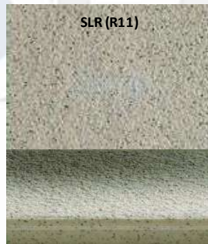
Estructura de la superficie
