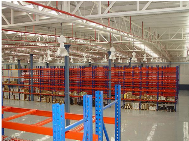
Sistema en acero estructural
